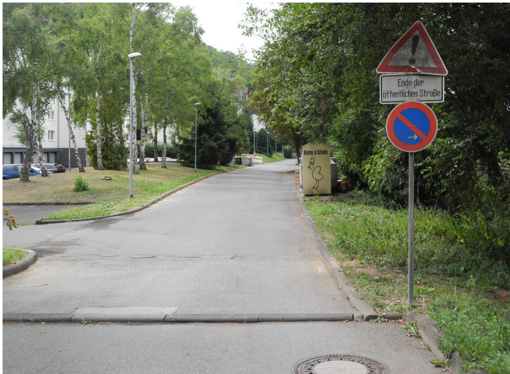
ABBILDUNG 41 (T2B): NORD-SÜD-HAUPTVERKEHRSACHSE CÖLBE-CAPPEL, BESTAND, BEISPIEL ABSCHNITT 134/CAPPELER STRAßE
