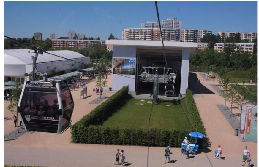
Beim Ein/Ausstieg werden Kabinen ausgekuppelt und verlangsamt, deswegen braucht man ausreichende Länge am Boden
